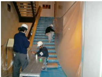
階段周囲養生
