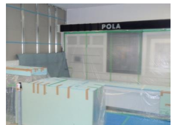
作業空間内保存物の保護養生
