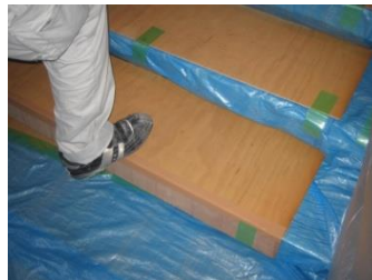
階段保護養生
