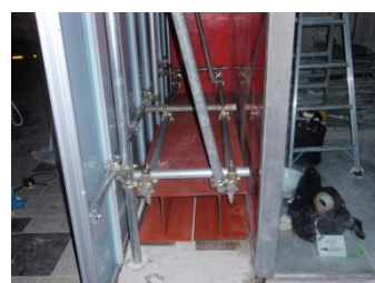
状況により、H鋼・枠組設置対応可
