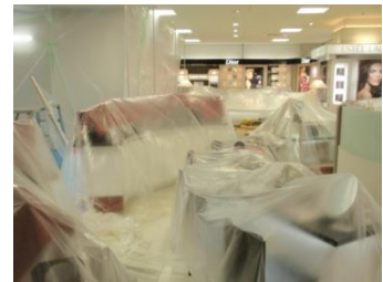
トンネル外側の商品ビニール養生
