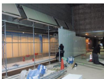
フラットパネル設置
