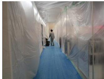
経路ビニールトンネル養生
