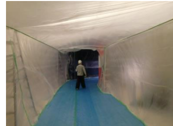
トンネル養生内部
