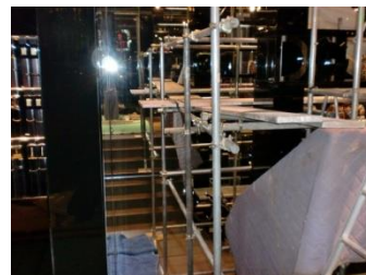
階段・踊場部足場組②
