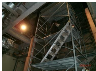
ローリングタワー設置②
