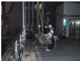
ユニック車にて資材揚重
