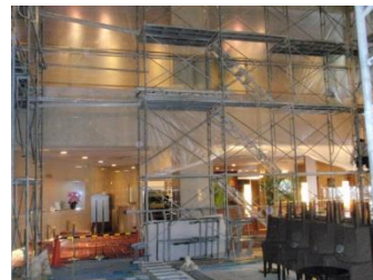
枠組足場設置
