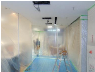
経路ビニールトンネル養生
