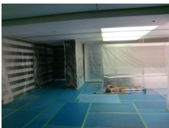
明装工事の為の場内保護仮設養生
