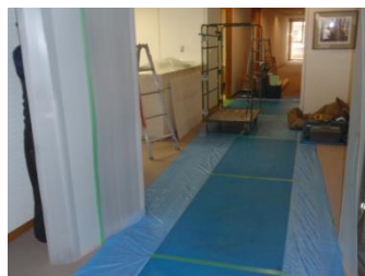
オフィスビルの明装工事用養生
