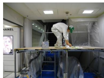
エスカレーター足場組②
