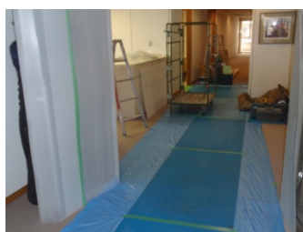
オフィスビルの明装工事用養生
