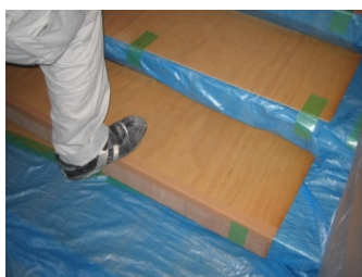
階段保護養生
