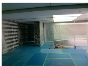
明装工事の為の場内保護仮設養生
