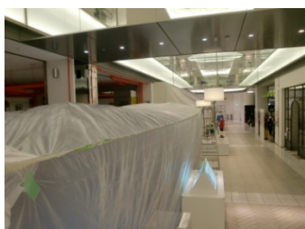
壁・天井完全ビニールトンネル養生
