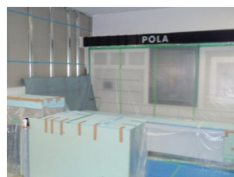
作業空間内保存物の保護養生
