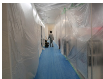
経路ビニールトンネル養生
