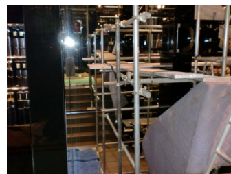
階段・踊場部足場組②
