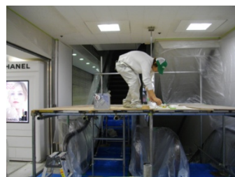
エスカレーター足場組②
