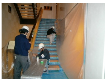
階段周囲養生
