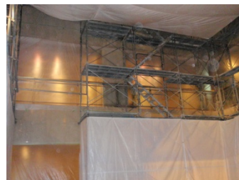
見掛け部分目隠し養生
