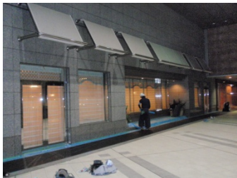
ブルーシート・ゴムシート養生
