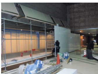
フラットパネル設置
