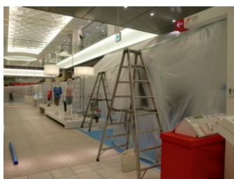
9尺脚立・足場等を利用
