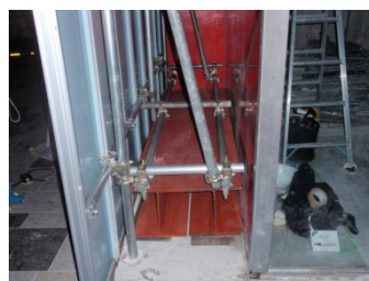
状況により、H鋼・枠組設置対応可
