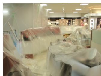
トンネル外側の商品ビニール養生
